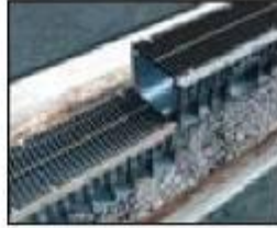
Kanalın oturtulması, hizalanması ve doldurulması
