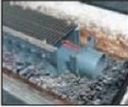
Kanalın oturtulması, hizalanması ve doldurulması
